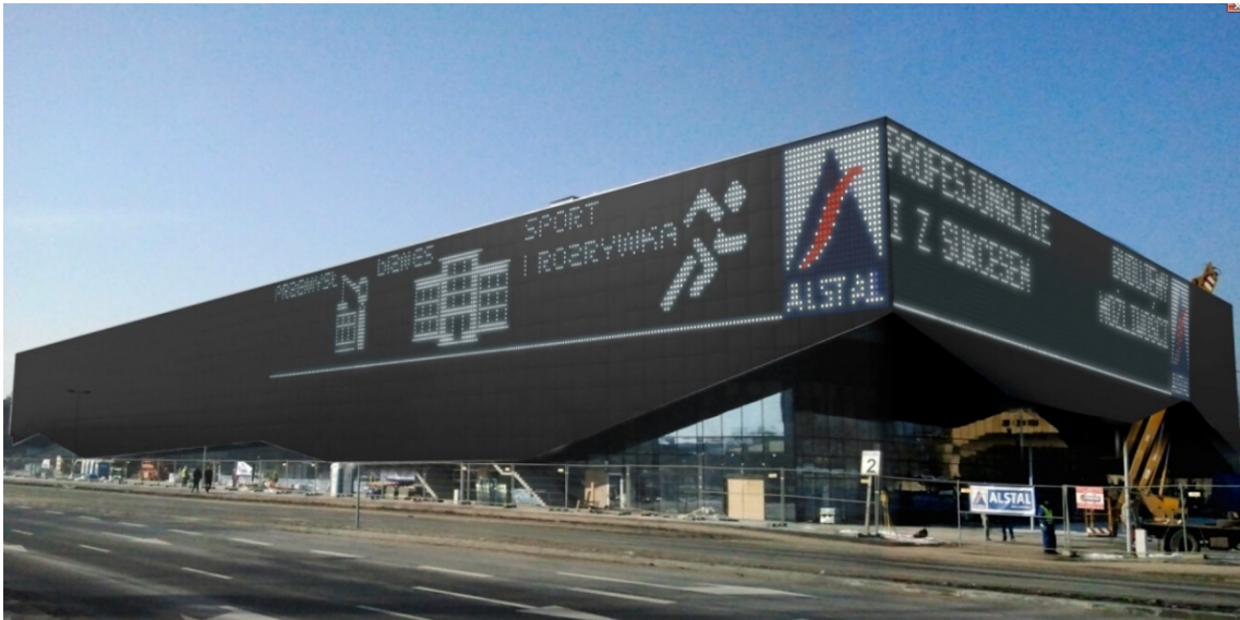
Sports Hall. Vista exterior de la façana.
